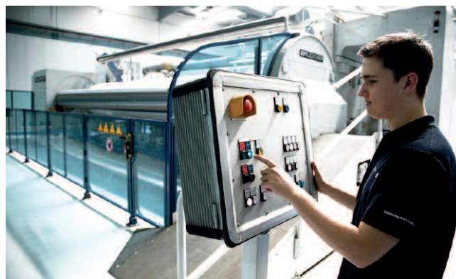
布吕克纳薄膜拉伸生产线
